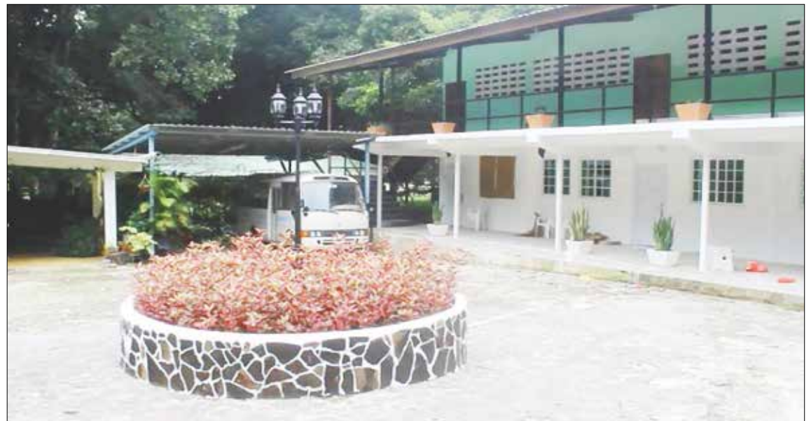
ESFUERZO. Trabajos realizados con esmero para brindar lo mejor a los fieles de la diócesis.
